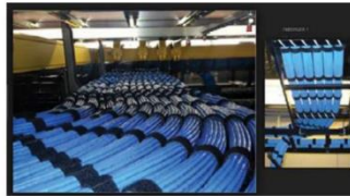
Espace nécessaire entre les faisceaux assurée par une sangle/ceinture
